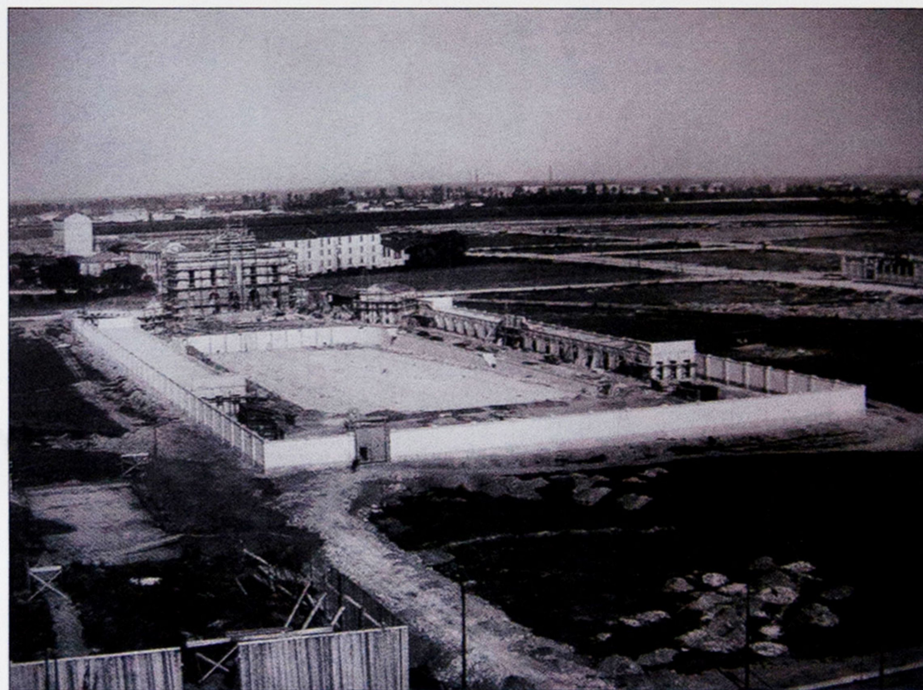
La piscina Ponzio in costruzione, 1929
